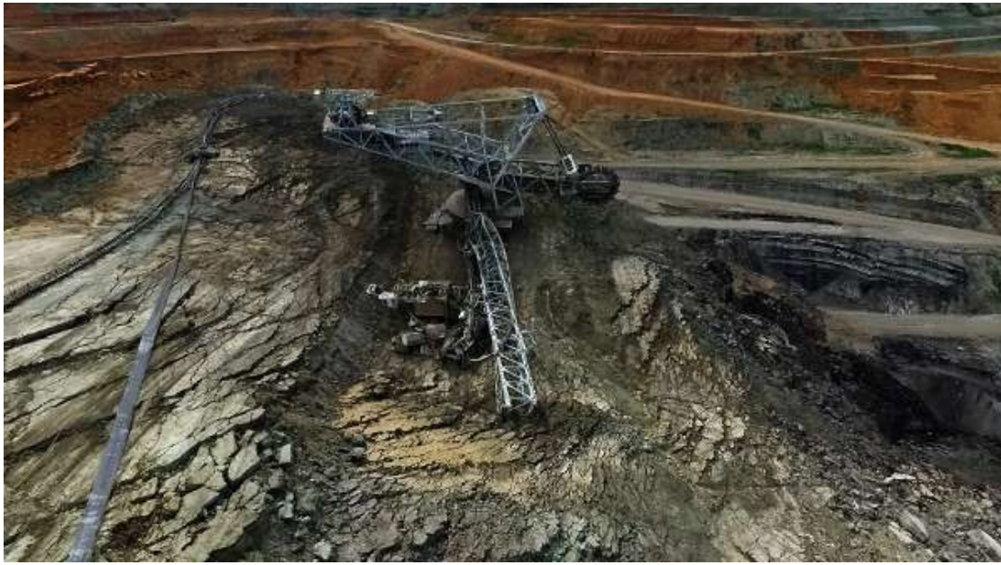
Γενική καταστροφή από αστοχία πρανών στο λιγνιτωρυχείο Αμυνταίου
