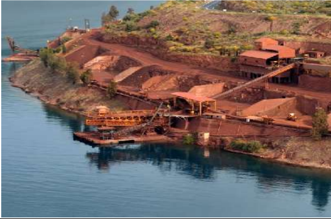
Άποψη σημείου φόρτισης βωξίτη στην Ιτέα
